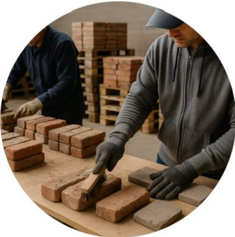
Nettoyage, démontage et tri sélectif de matériaux
